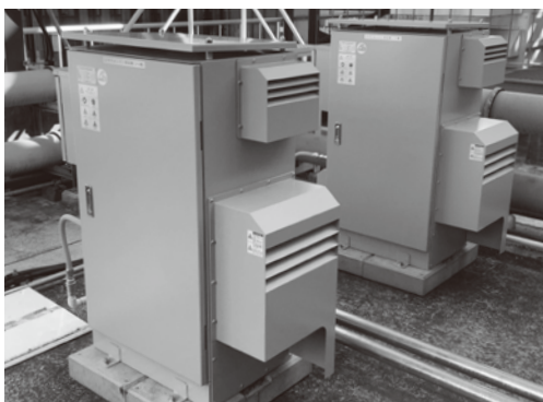
ビル屋上に設置した2台のLPガス発電機
